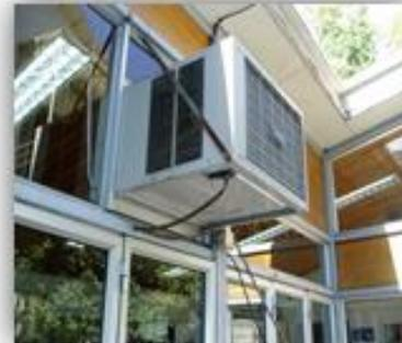
Algunos de estos equipos presentan un bajo nivel de eficiencia energética (COP/EER) y aún emplean refrigerante R-22, de bajo rendimiento, aunque la tendencia es sustituir este gas por otros de mayor eficiencia, como el R-407C ó R-410A.
