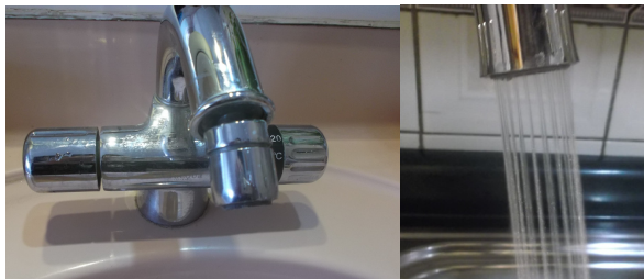
Figura 4: Aireador de flujo fino para caudales de 2 y 4 L/minuto.
